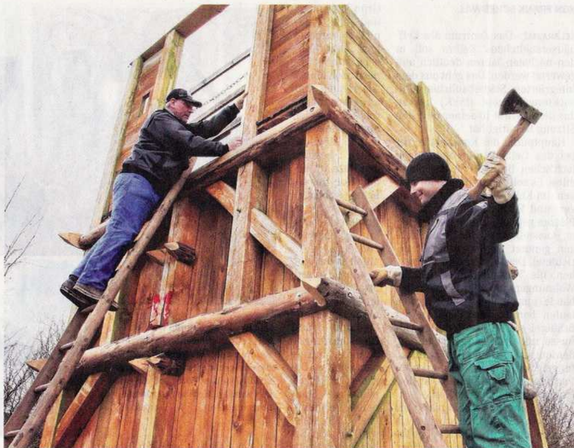
Während der Winterpause wurde der Belagerungsturm der Pfalz ausgebessert.
